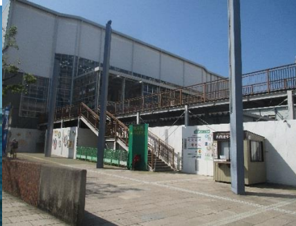
↑ 工事中の門司港駅舎
